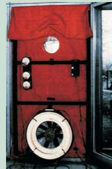
Prüfung der Luftdichtigkeit mit dem Blower-Door-Gerät
